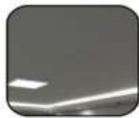
Forro em gesso
