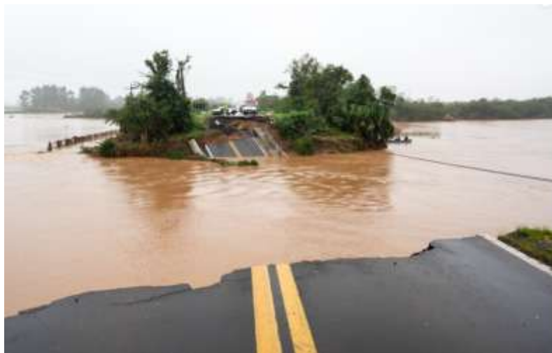
Figura 2. Colapso da ponte sobre o Arroio Grande, na rodovia RS-287, em Santa Maria (RS), causado por intensas chuvas no mês de maio de 2024. A imagem mostra a destruição da estrutura e o alagamento da área, comprometendo a mobilidade local. [3]
