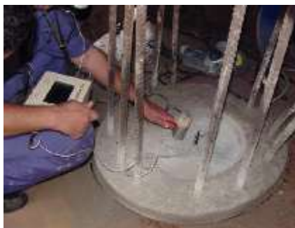
Figura 05 - Ensaio de integridade de estacas (PIT) [10]
