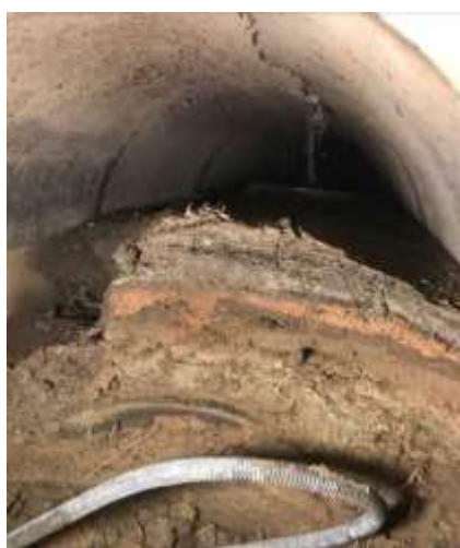
Figura 2. Recuperação da canalização de águas pluviais (depois). [16]
